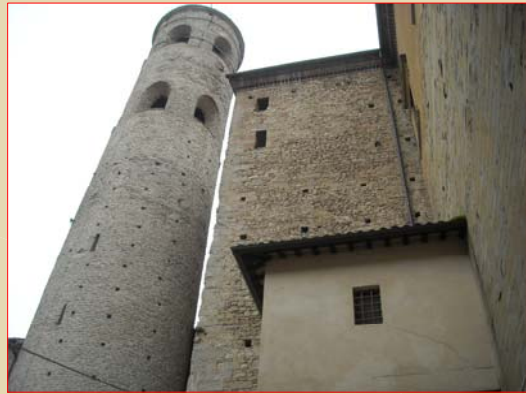
illuminazione monumentale Campanile cilindrico
