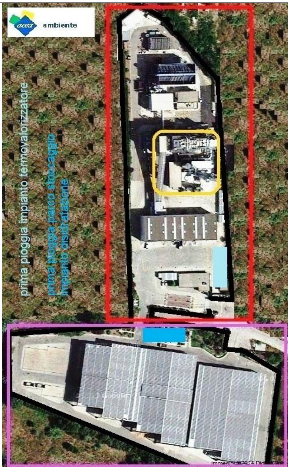
VEDUTA AEREA CON POSIZIONAMENTO VASCHE PRIMA PIOGGIA
