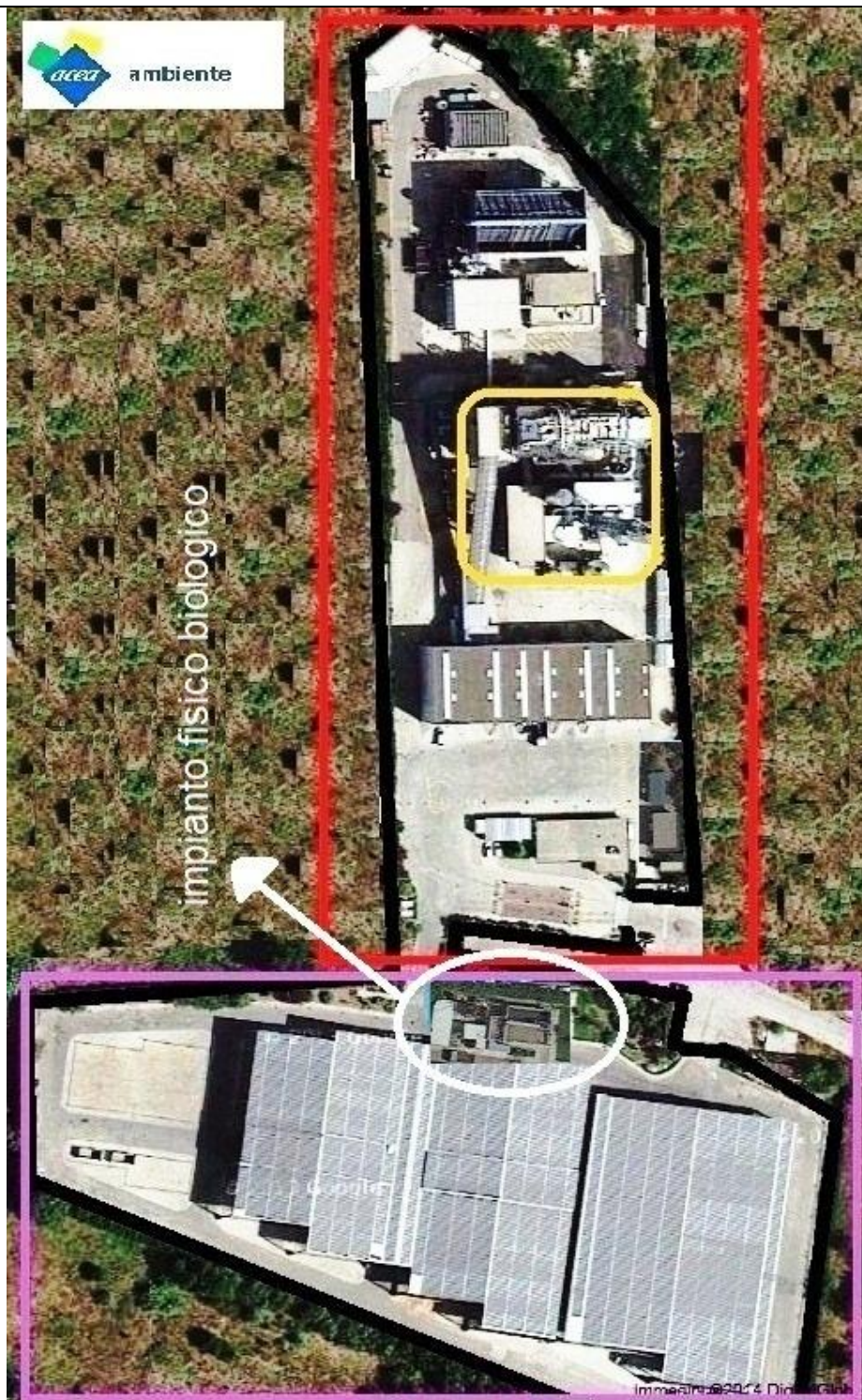
VEDUTA AEREA CON IDENTIFICAZIONE DELL'IMPIANTO DEPURAZIONE FISICO BIOLOGICO
