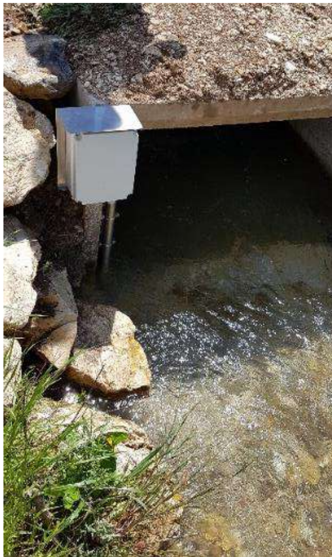
Figura 1.16 Sonda situata lungo il torrente a valle dell'emergenza della sorgente del Torbidone (TT1).
