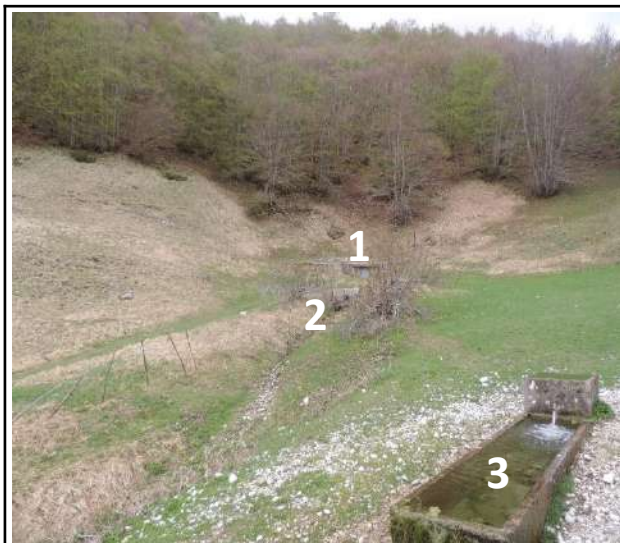
1) Opera di presa della VUS; 2) rilascio; 3) abbeveratoio. La portata complessiva misurata il 05-05-2017, data dalla somma di 1+2+3, è pari a: (8.5+0.1+1.1) = 9.7 l/s.
