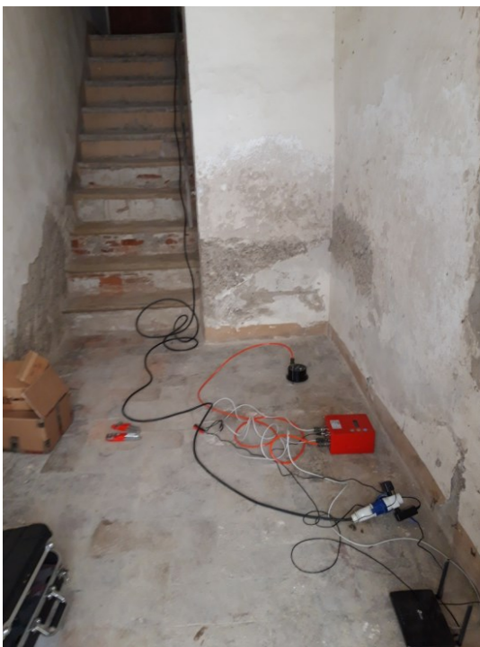
Stazione accelerometrica di Città di Castello
