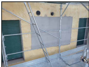
RIPRESA DI INTONACI
