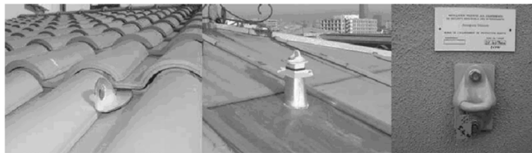
Ancoraggio di tipo "A2"
