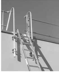
4. Scala portatile vincolata alla zona di sbarco
