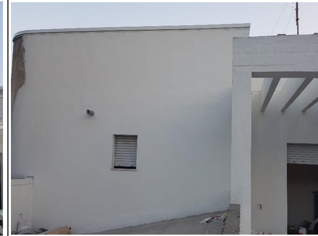
foto 2 - dopo il trattamento di lavaggio
