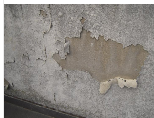
foto 4 - rimozione rivestimento plastico
