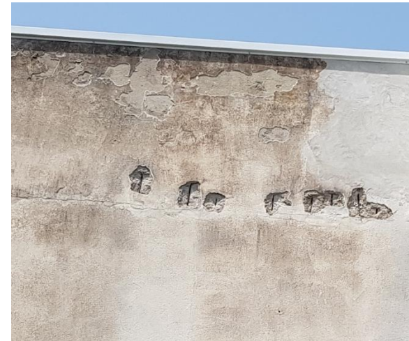
foto 3 - trattamento dei ferri esposti
