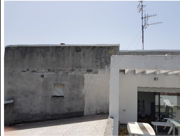
foto 1 - prima del trattamento di lavaggio
