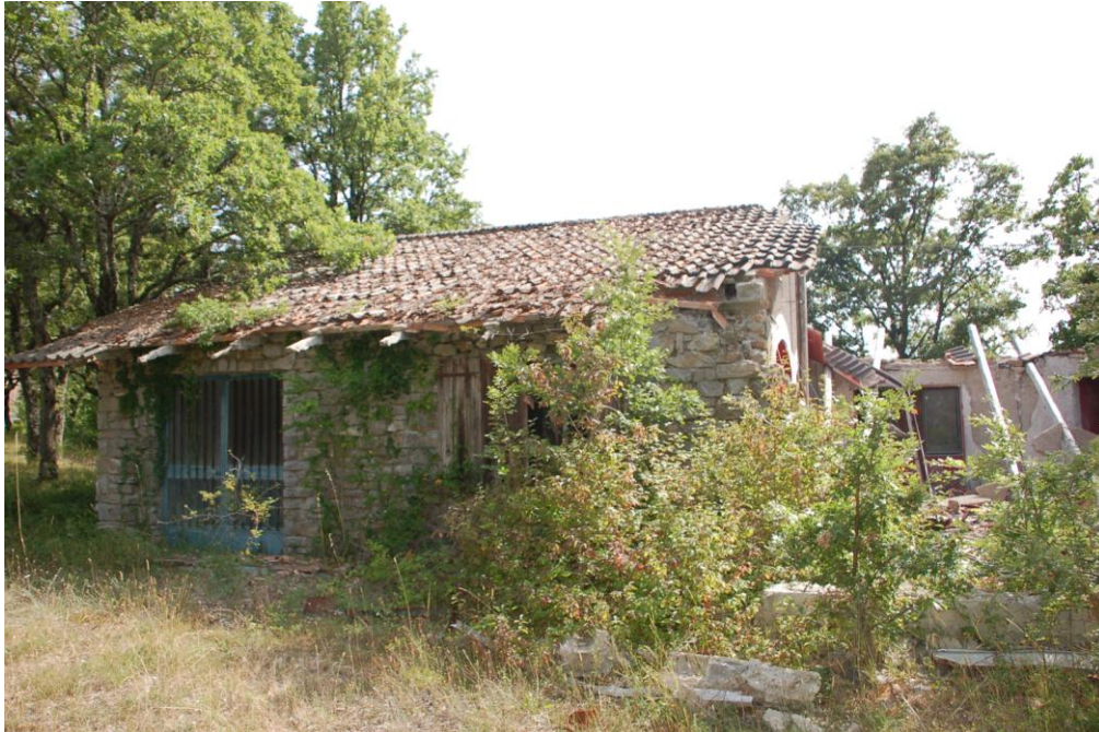
Figura 3 - Possibile edificio rifugio per i chiroterri
