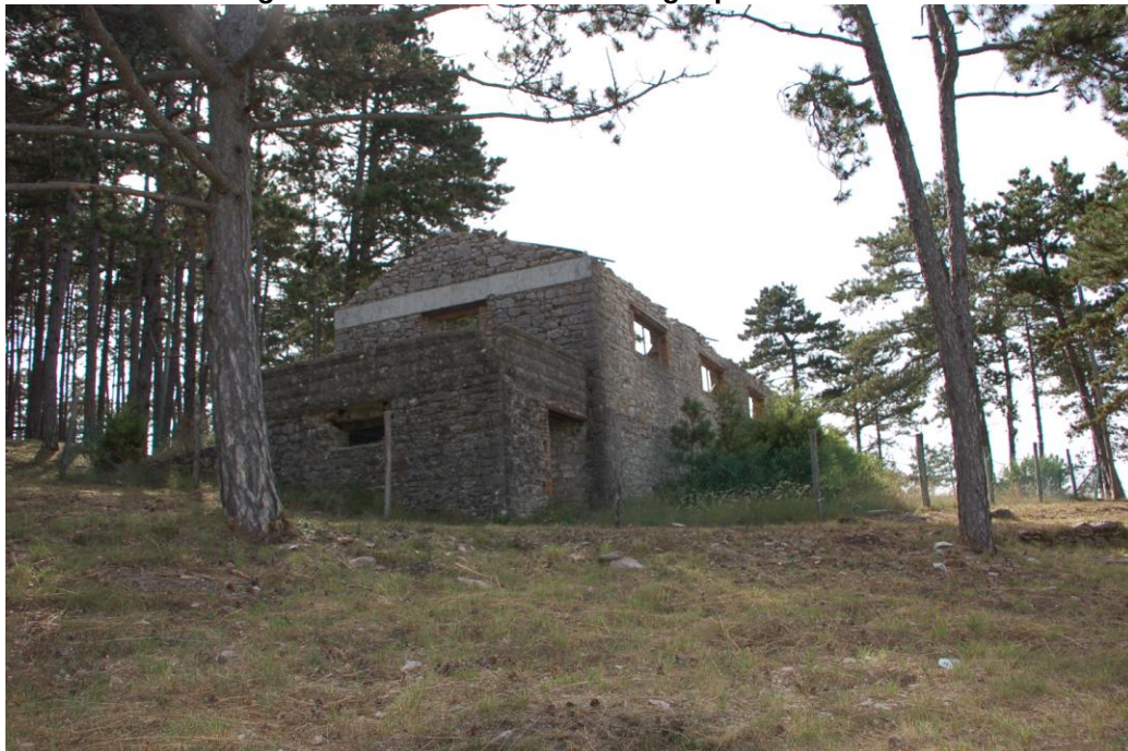
Figura 4 - Possibile edificio rifugio per i chiroterri
