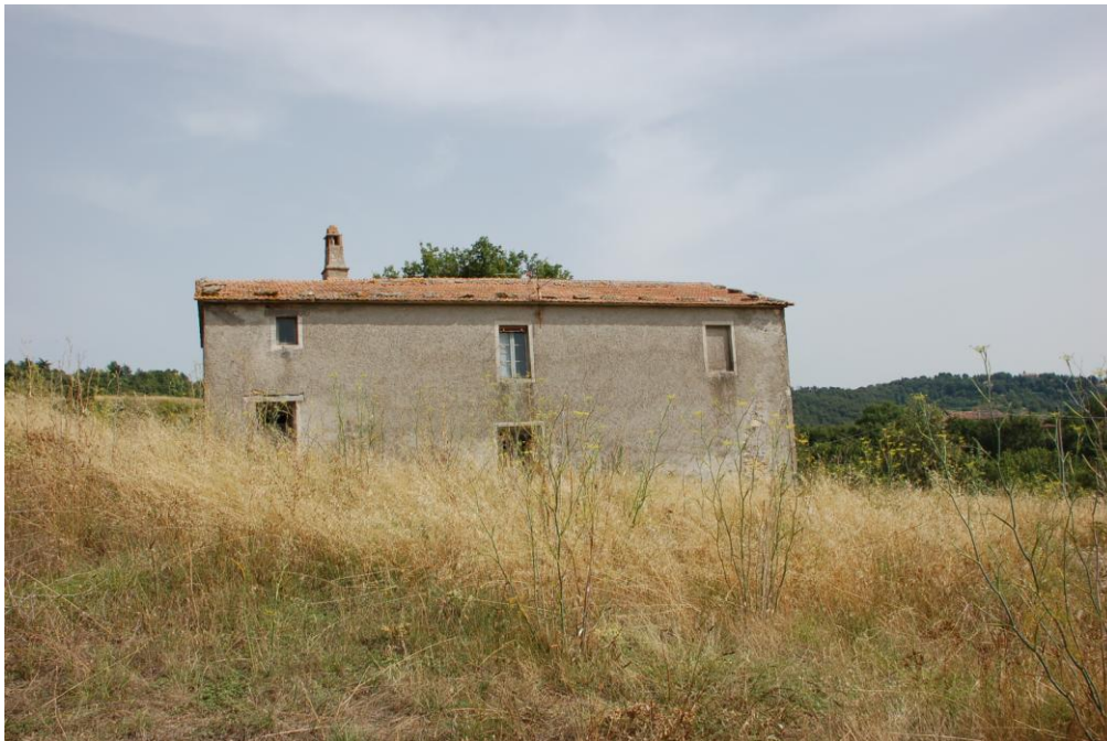
Figura 2 - Possibile edificio rifugio per i chirotteri
