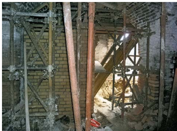
Cedimento fondale e realizzazione di opere provvisorie di sostegno
