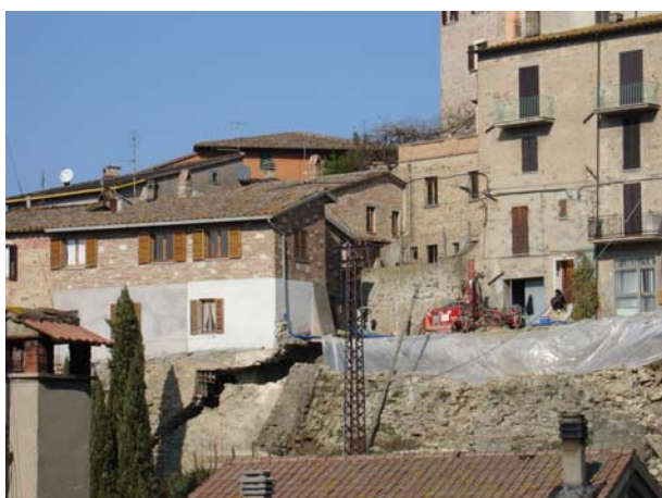
Realizzazione della paratia di micropali
