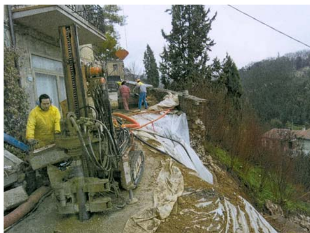
Realizzazione della paratia di micropali
