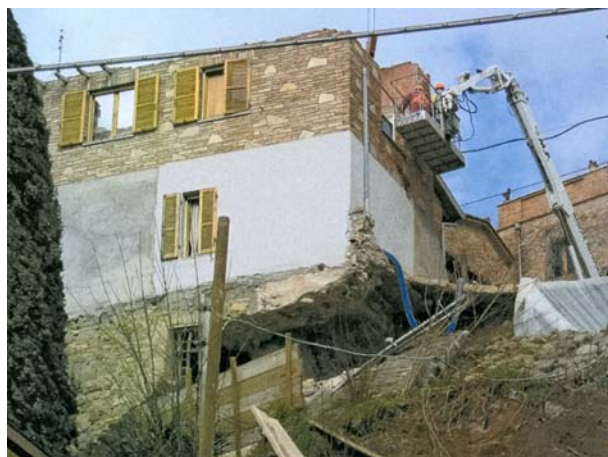
Demolizione di parte di edificio pericolante
