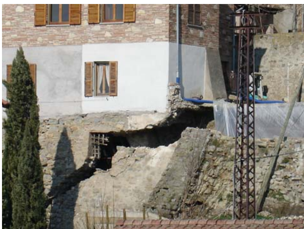
Cedimento fondale e realizzazione di opere provvisorie di sostegno
