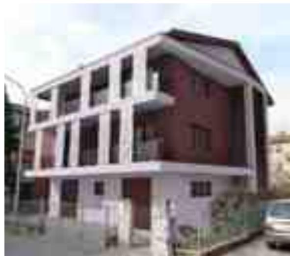
corrispondenza del lato lungo dell'edificio. In particolare il corpo scala è posto all'interno del corpo edilizio mentre il corpo contenente l'ascensore, oggetto di un intervento successivo al primo impianto, è stato collocato a filo esterno. All'esterno l'edificio risulta fortemente caratterizzato grazie all'introduzione di elementi frangisole, finalizzati al controllo delle radiazioni solari.
