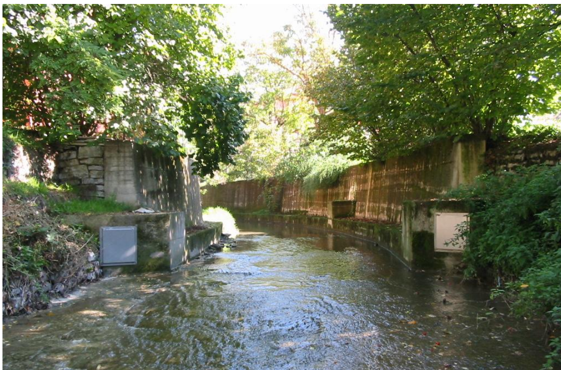
Figura 15: Vista da valle del termine dei collettori fognari laterali e del relativo By-pass nel torrente Scatorbia posti circa 40 metri a monte dell'immissione del fiume Tevere del torrente Scatorbia.
