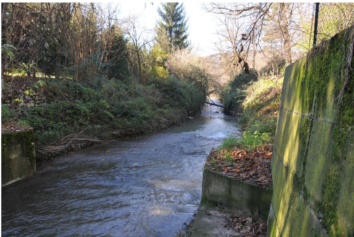
Figura 16: Vista da monte del termine dei collettori fognari laterali e del relativo By-pass nel torrente Scatorbia posti circa 40 metri a monte dell'immissione del fiume Tevere del torrente Scatorbia in fondo alla foto.
