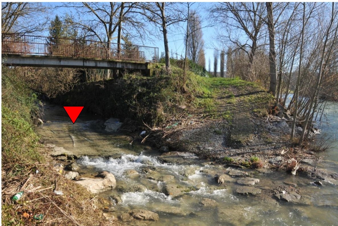
Figura 14: Briglia in massi situata in corrispondenza della confluenza del torrente Scatorbia nel fiume Tevere. È indicato con la freccia rossa il livello massimo che il fiume Tevere dovrebbe raggiungere in caso di realizzazione della centrale
