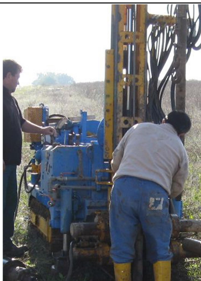
Foto 3 – Sondaggio geognostico S1
